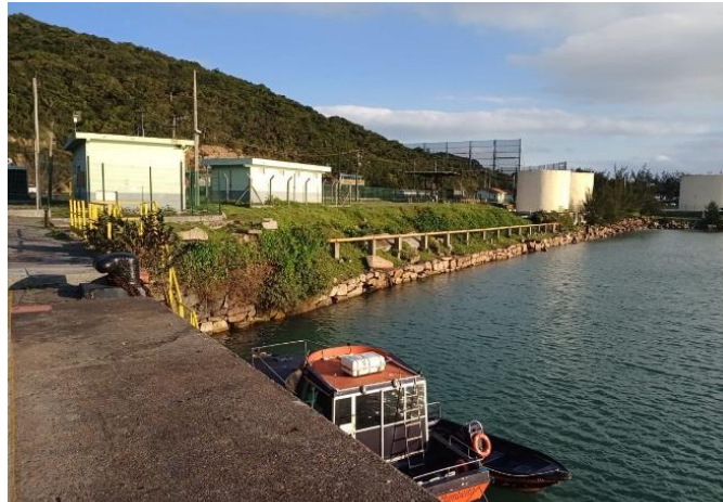
Figura 5 - Muro de pedras Cais 1
