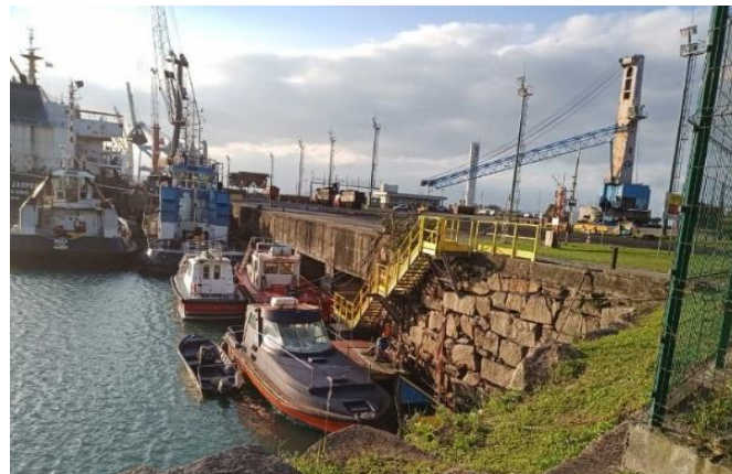
Figura 6 – Estrutura inicial do Cais 1.
