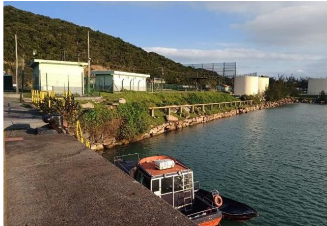
Figura 5 - Muro de pedras Cais 1
