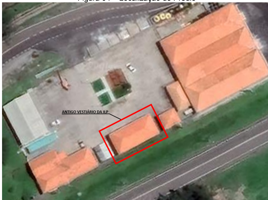
Figura 04 – Localização do Prédio
